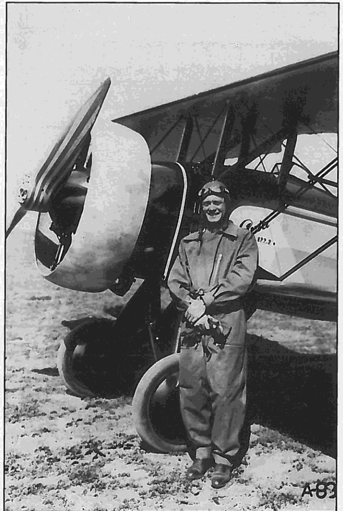
Der Kunstflieger Novak vor seiner Avia in einem Stadium der Erprobung der Motorverkleidung mit einem Townend-Ring
